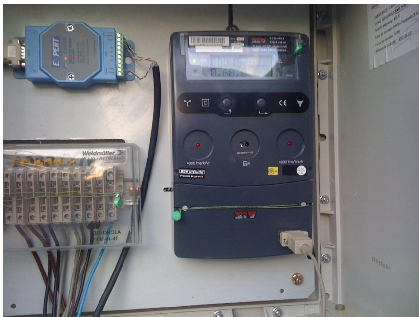
Figura 11. Contador de energía con convertidor RS232/RS485
