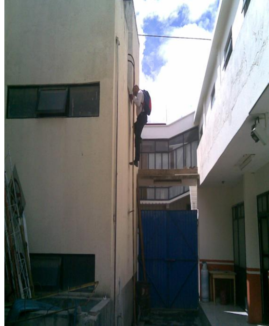
A la izq. (Fig. 4.6) Azotea del Ayuntamiento; a la der. (Fig. 4.7) Acceso a la azotea del Ayuntamiento
